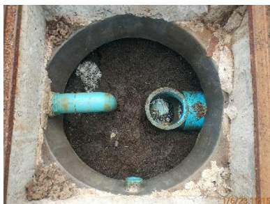
บ่อกักน้ำก่อนเข้าสู่ระบบระบบบำบัดน้ำเสีย ชุดที่ 1
